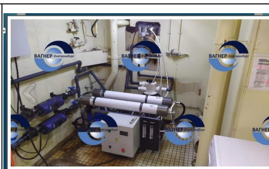
Рисунок 2 – Опреснительная установка, разработанная в рамках программы освоения инноваций, установлена на судне В. Буйницкий г. Мурманск 2021 г.
